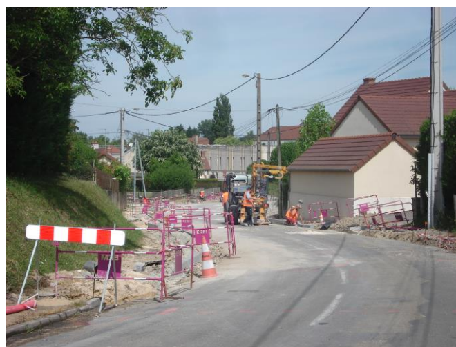
Photo prise le 26 juin 2015, les travaux avancent.....
