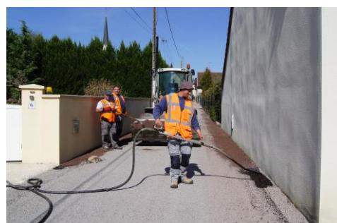
Ruelle de l'Arnison, travaux qui se terminent....le 13/04/15
