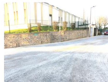
Route de la Forêt terminée
