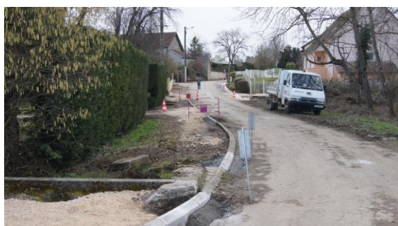
Travaux de la rue de la Forêt le 25/02/2015
