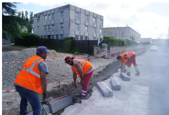
Photo prise le 2 juin 2015, pose des trottoirs...
