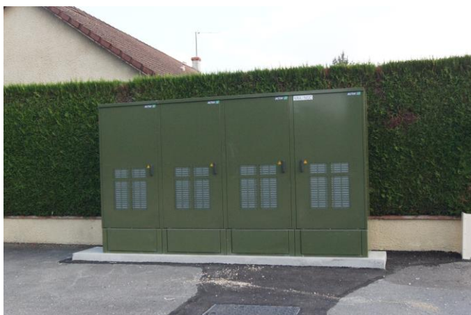
Installation de l'armoire de la fibre optique, bientôt la fibre !! Photo prise le 24/08/2017
